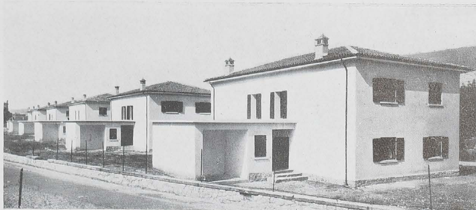
In alto, Volargne (Verona). Una parte delle casette isolate già costruite, vista dal lato dei rustici.
